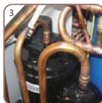
Серебряная сварка газовых труб
